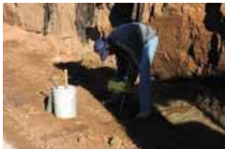
Verdichting regelmatig controleren
