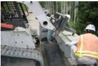
Extra lagen plaatsen, geogrid keermuur
