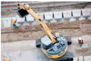
Extra lagen plaatsen, zelfdragende keermuur
