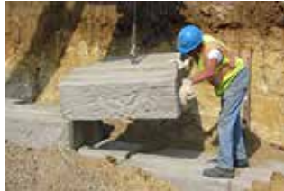
Lagen plaatsen, zelfdragende keermuur
