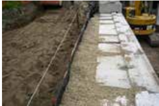
Het drainagemateriaal plaatsen
